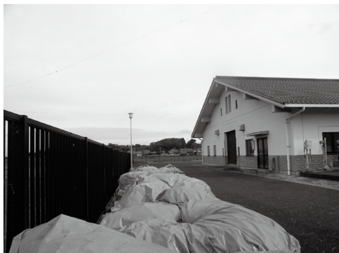
▲脱水汚泥の仮置き状況(新治地区農業集落排水処理施設)
