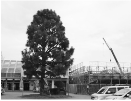
▲下稲吉小学校工事風景
