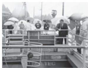
▲下水道線越工事現場の調査(加茂地内)
