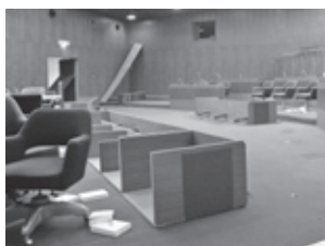
▲被災した議場
