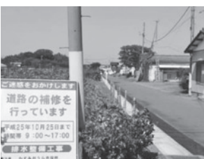
▲排水整備工事
