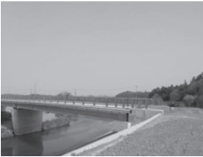
▲五輪堂橋改修工事現場
