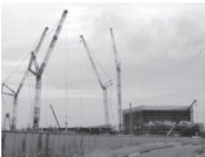
▲土浦協同病院の移転新築現場
