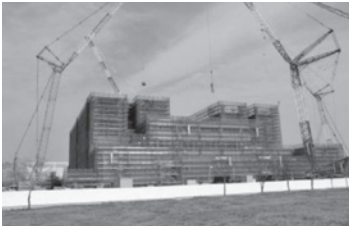
▲土浦協同病院の移転新築現場
