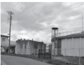
▲水道施設（下稲吉第二機場）
