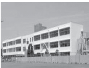
▲大規模改修工事の続く美並小学校
