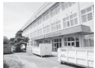
▲改造工事の始まる北小学校 (旧北中学校)
