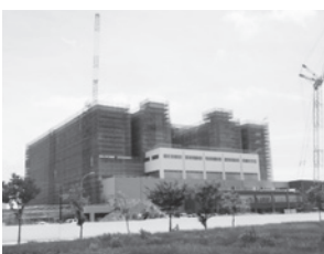
▲建築工事が進む土浦協同病院
