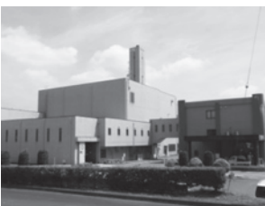
▲新治地方広域ごみ処理場
