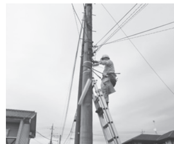
▲LED防犯灯工事
