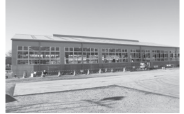
建設が進む美並小学校プール
