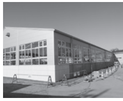
▲改築中のプール
