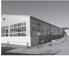
▲改築中のプール
