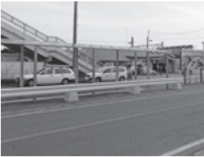
▲工事中のJR神立駅
