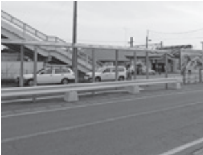
▲工事中のJR神立駅
