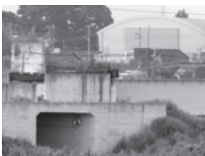
▲工事中の国道6号バイパス (東野寺地内から撮影)
