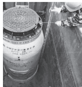
▲昨年度のマンホール工事の様子
