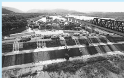
▲平成30年7月8日岡山県倉敷市における緊急排水作業の様子(出典 国土交通省ウェブサイト)
