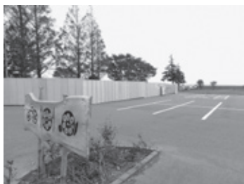
▲改築工事中のトイレ(歩崎公園)
