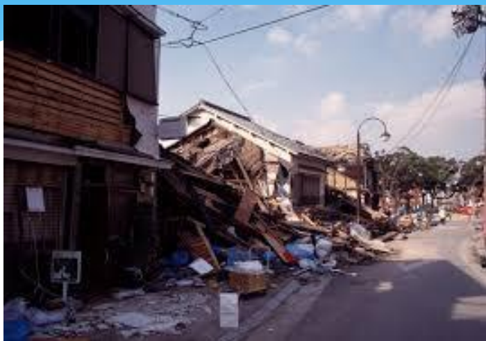
◀大阪府北部地震 平成30年6月18日
