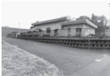
▲土田地区農業集落排水処理施設
