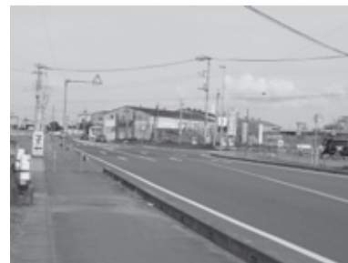
▲国道354号（大和田地内）
