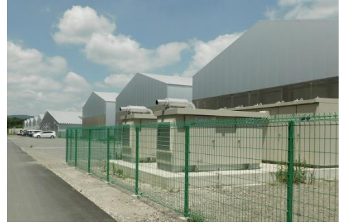
( 建設中の鶏舎 )
