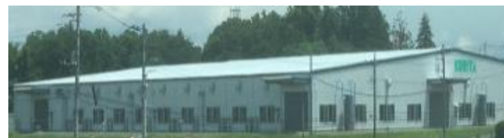
H30.6に操業開始した新工場
