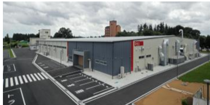
建設中の新工場
