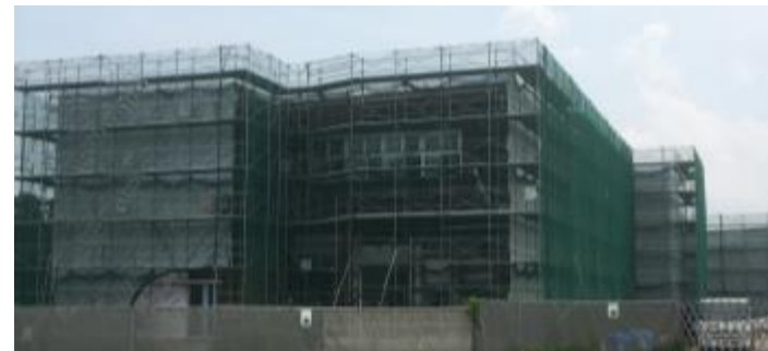
建設中の新工場
