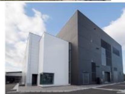
H29.1に操業開始した新工場
