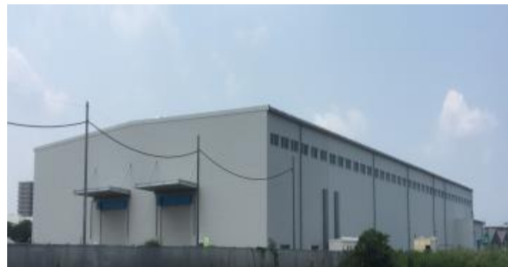
建設中の新工場
