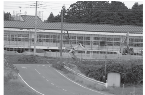
▲ウエルネスプラザとして工事中の旧穴倉小学校
