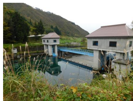
(農業用水を引き入れる佐梨川 小出郷第1号頭首工)
