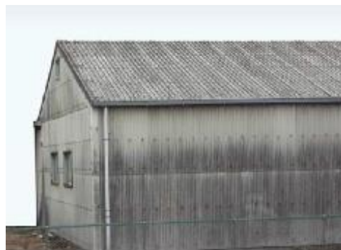
石綿含有スレート波板（屋根・外壁）
