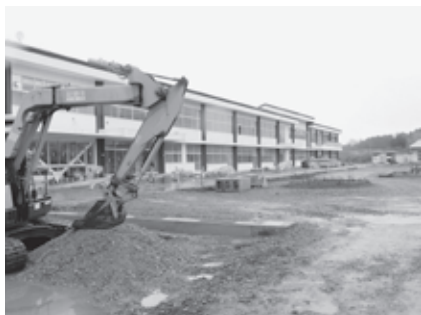
▲工事中のかすみがうらウエルネスプラザ 【穴倉地内】
