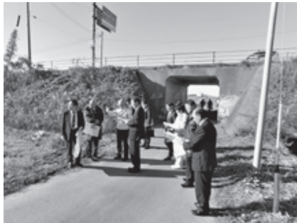
▲市道認定箇所の現地調査 【田伏地内】
