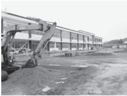
▲工事中のかすみがうらウエルネスプラザ 【宍倉地内】
