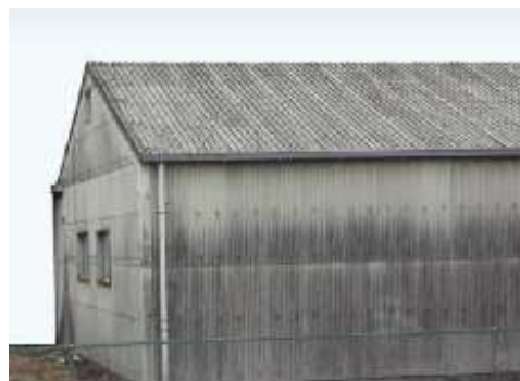
石綿含有スレート波板（屋根・外壁）
