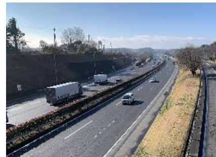
(常磐自動車道千代田パーキングエリア付近)
