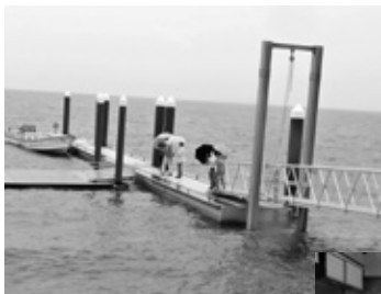
▲歩崎栈橋の現地調査 【坂地先】
