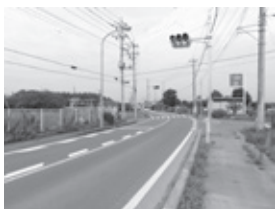
▲国道354号 (戸崎地内)
