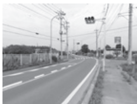
▲国道354号 (戸崎地内)
