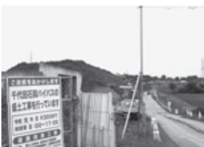
▲工事が進む千代田石岡バイパス（市川地内）
