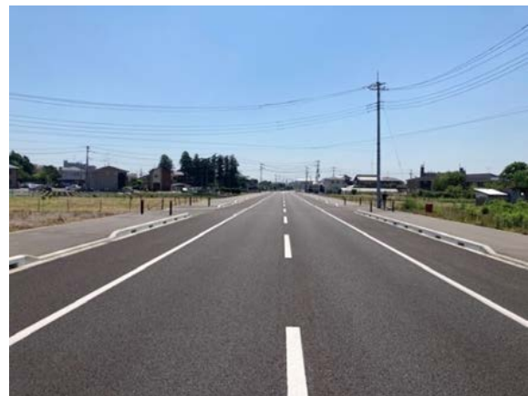
都市計画道路神立停車場線 (令和2年3月26日全線供用開始)
