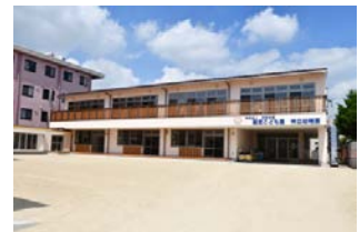
(整備園舎の外観-神立幼稚園-)
