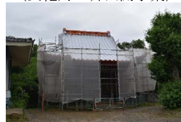
(修繕中の千手観音堂)
