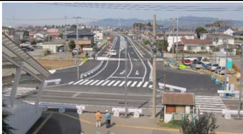
神立駅西口周辺整備状況
