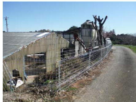
【防護柵設置の様子】
