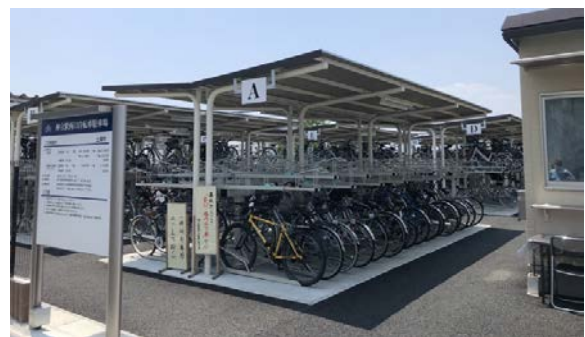
神立駅西口自転車駐車場
