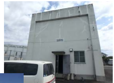
出島揚水牛渡機場
