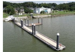
「歩崎棧橋」の設置
