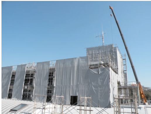
▲千代田庁舎耐震補強工事
