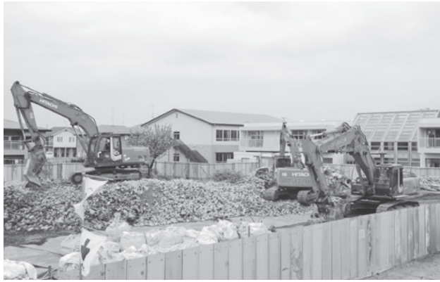
▲下稲吉小学校屋内運動場改築工事
