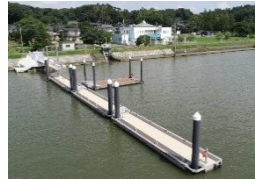
「歩崎棧橋」の設置
