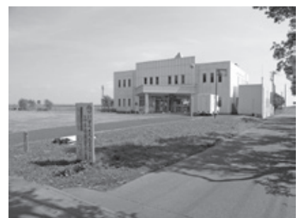
▲アクティビティ拠点倉庫設置予定地 (かすみがうら市交流センター前)
