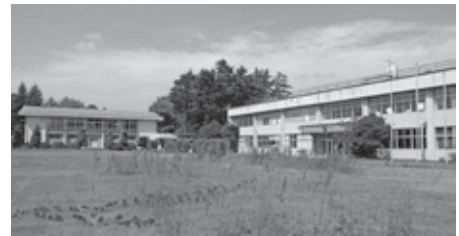
▲解体予定の旧下大津小学校校舎・体育館
