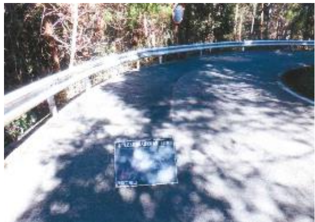
林道雪入沢線 補修箇所
