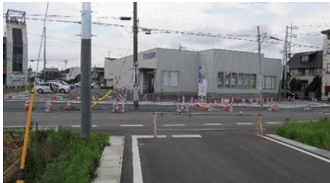
4 街区店舗移転完了
