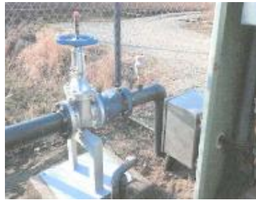
小規模土地改良事業 【美土地改良水利組合】 ポンプ交換
