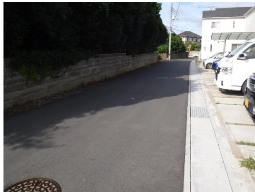
市道8-0445号線道路排水整備工事完了写真
