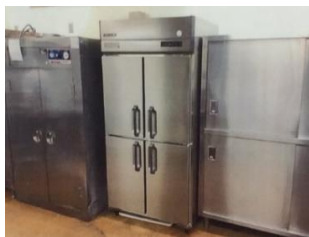
更新した調理設備 業務用冷蔵庫
