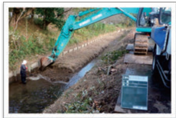
〔浚渫工事（雪入川）〕
