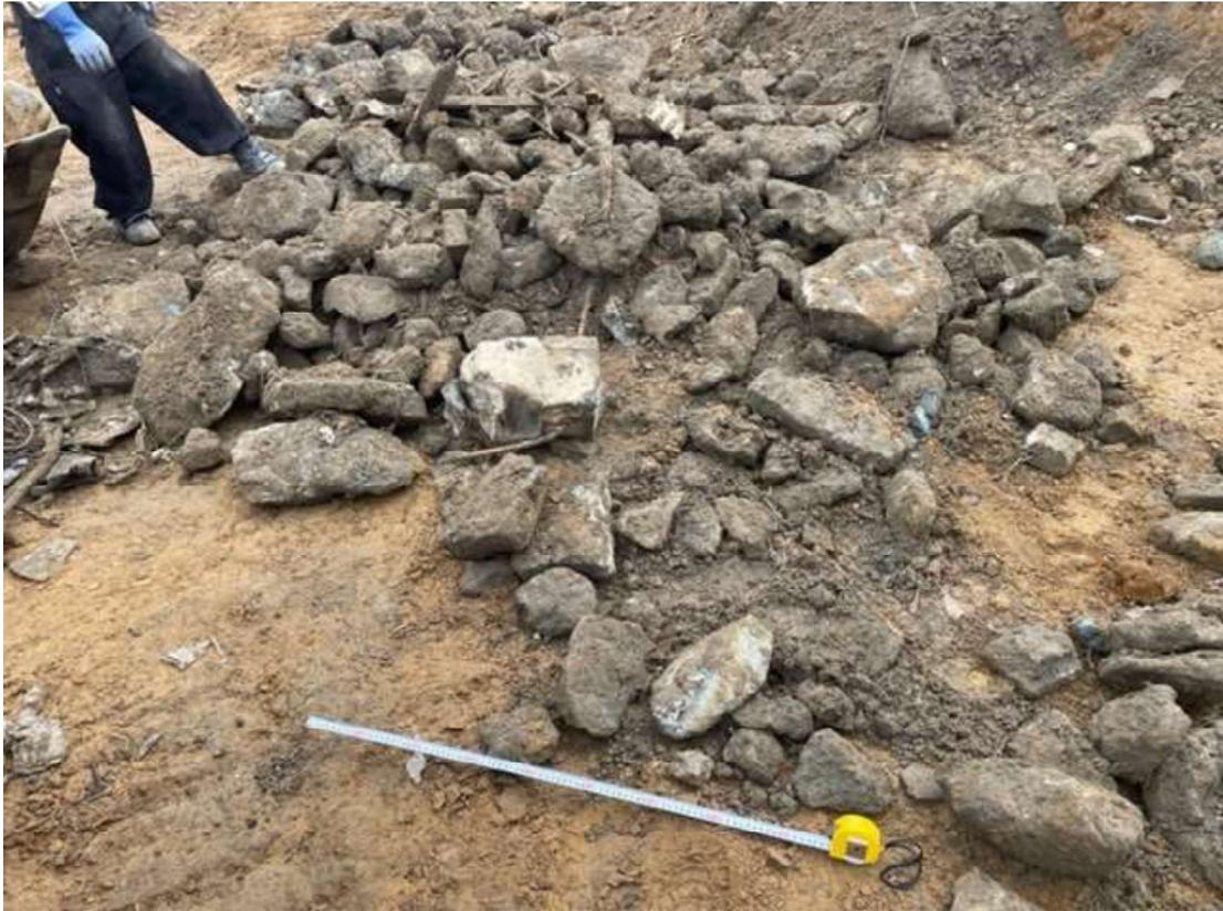
(ウ) 埋設物を分別し処分場へ運搬する。処分状況は、電子マニフェストで管理する。コンクリートガラについては、主に、つくば市、小美玉市の再生資源施設へ運び入れている。
