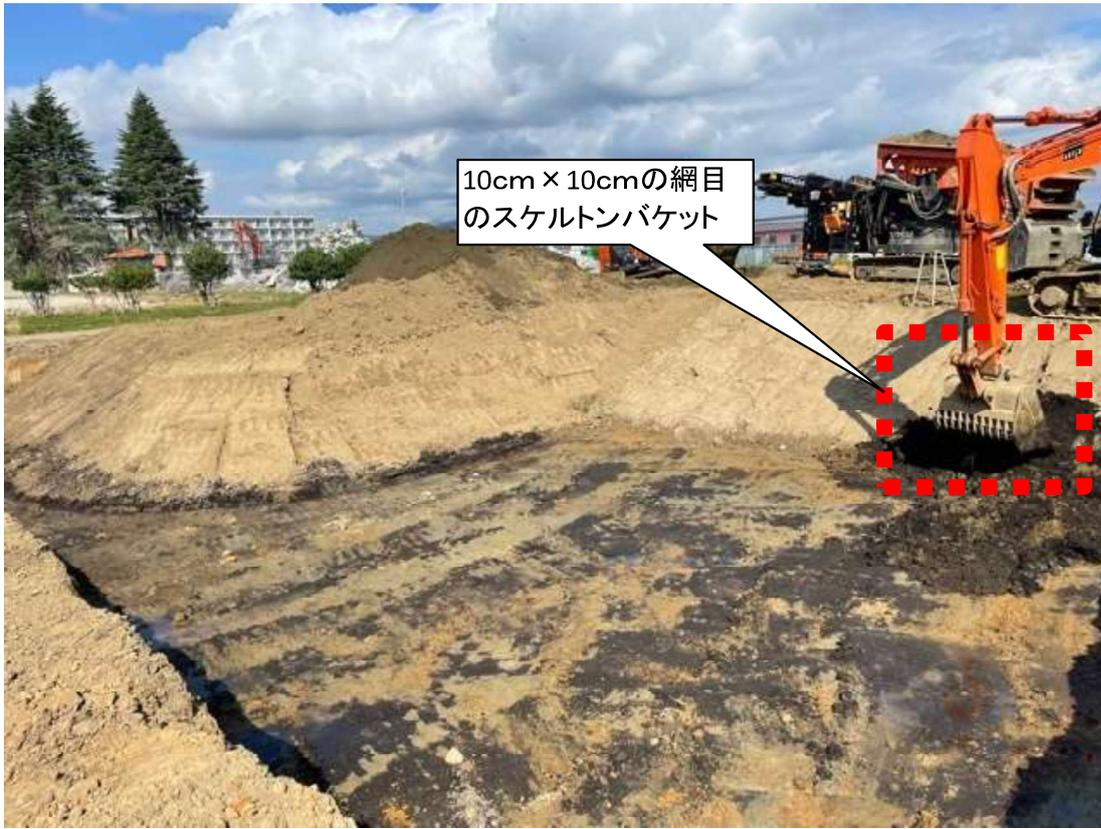
(ア) 10cm×10cmの網目のスケルトンバケット付きバックホウで、対象区画を掘削する。地山又はGL-2.5mまで掘削する。
