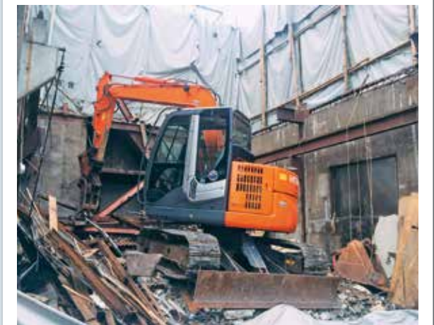
空き家解体のイメージ
