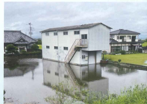
豪雨による霞ヶ浦湖岸の堤防の内側の冠水状況
