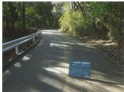
上佐谷・青木葉線の補修状況
