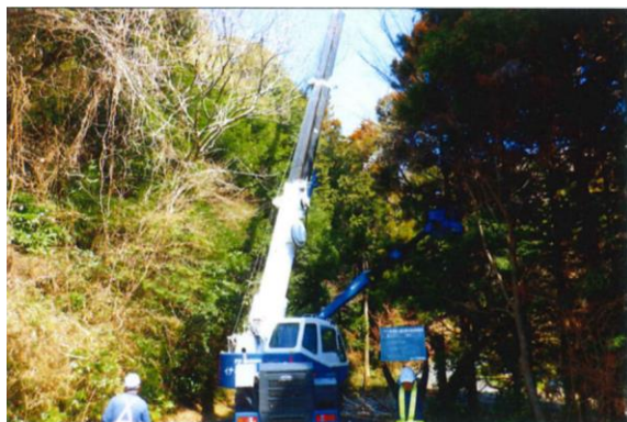
林道支障木の伐採状況
