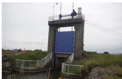
修繕した柏崎船溜樋門ゲート
