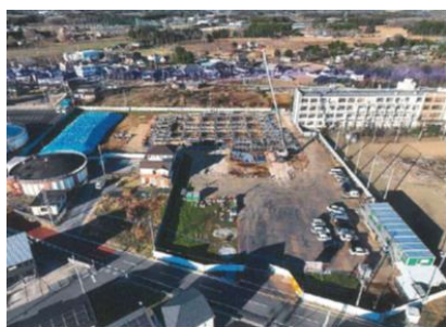
下稲吉中学校体育館新築工事状況
