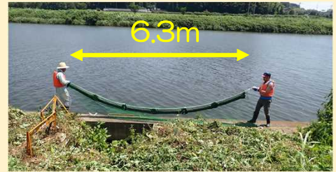
ポンプ場の取水スクリーン前への設置の様子
