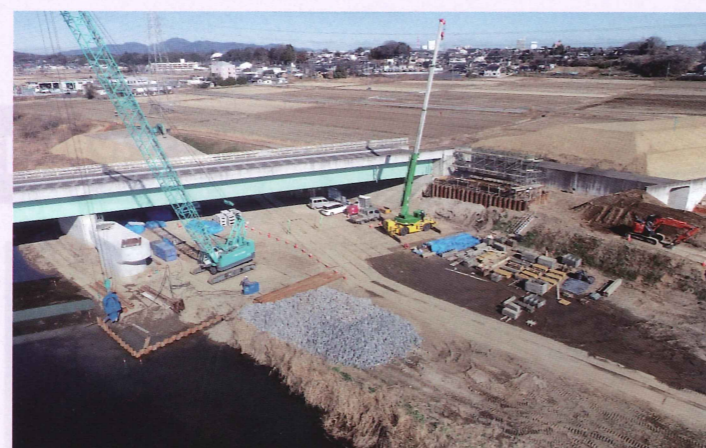
▲恋瀬橋下部工事
