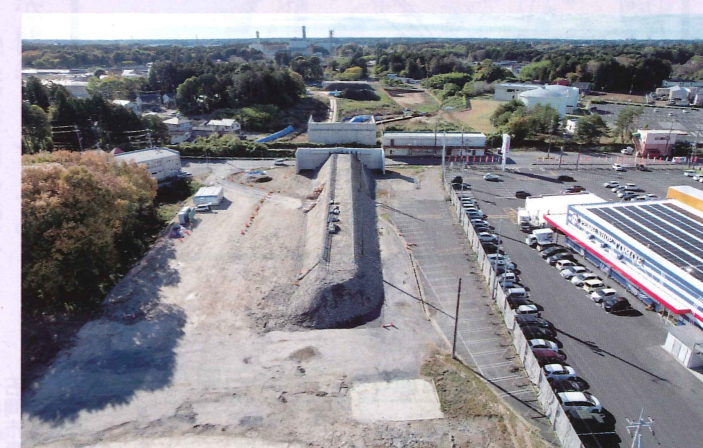
▲玉里高架橋上部工事
