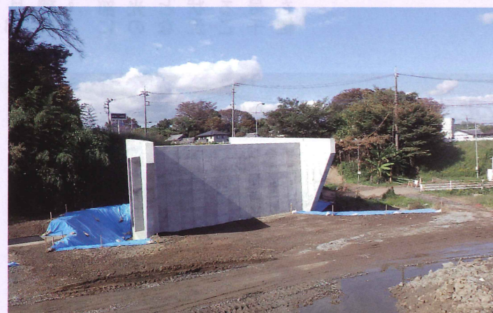
▲市川地区改良工事
