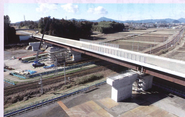
▲東田中高架橋下部工事
