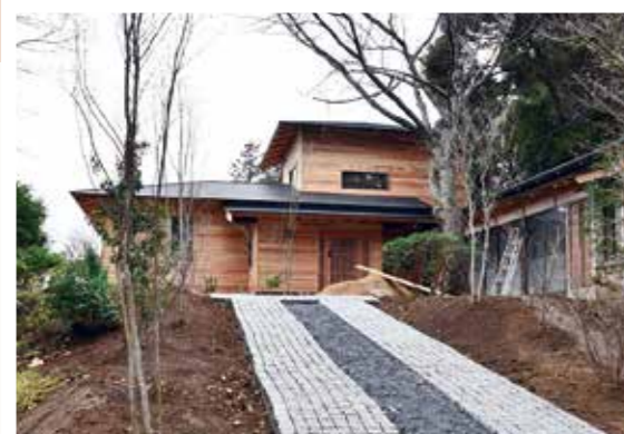
【写真】改修中の水郷園の外観（歩崎地域）
